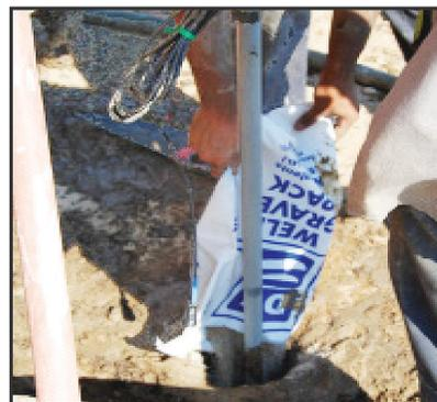
3. Entourez le géophone en sondage et le câble de gravier.
