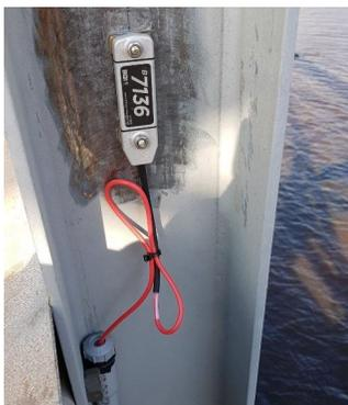
Installation d'une jauge de déformation
