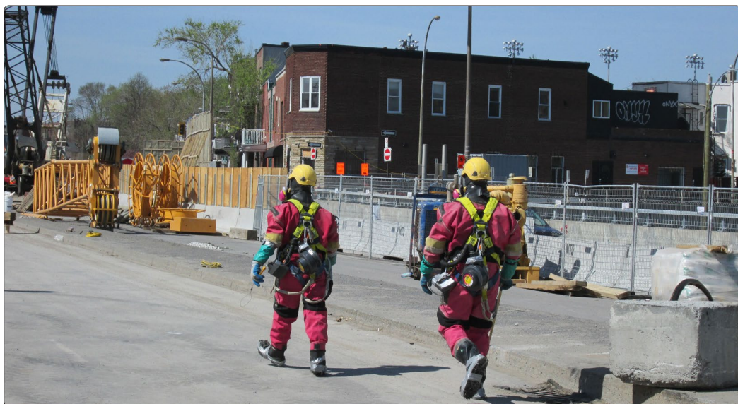
Lieu des travaux
