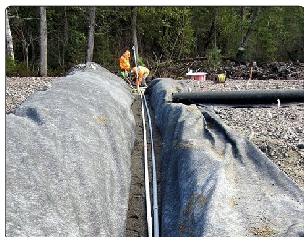
◆ Installation d'un Shape Accel Array (SAA) à l'horizontale
