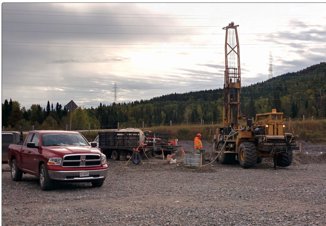
Installation de piézomètres dans des forages géotechniques
