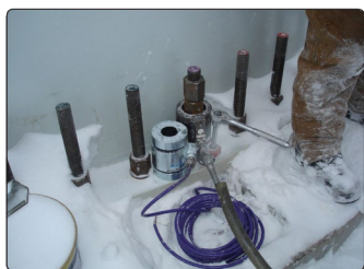
♦ Installation de cellules de charge aux ancrages
