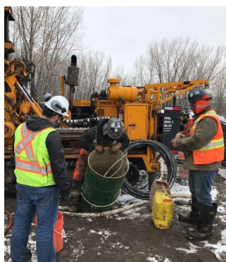
Préparation de l'injection du coulis de ciment
