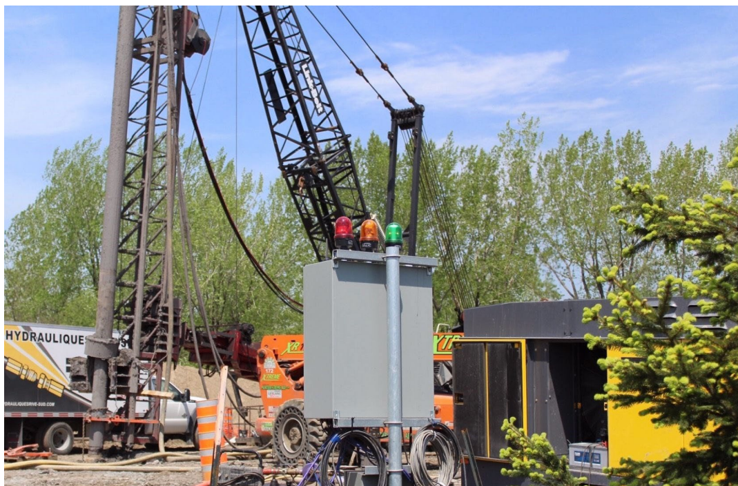
Passerelle Normandie Longueuil Québec | Surveillance de vibration durant le battage des pieux
