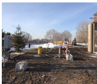
Vue générale du site de construction
