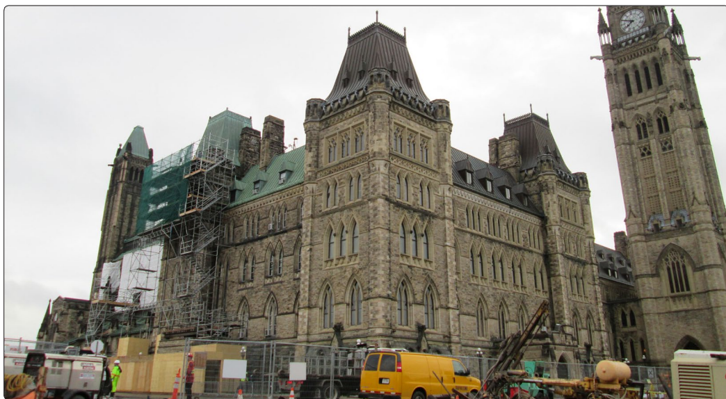
Vue des travaux de l'édifice de l'Ouest du Parlement
