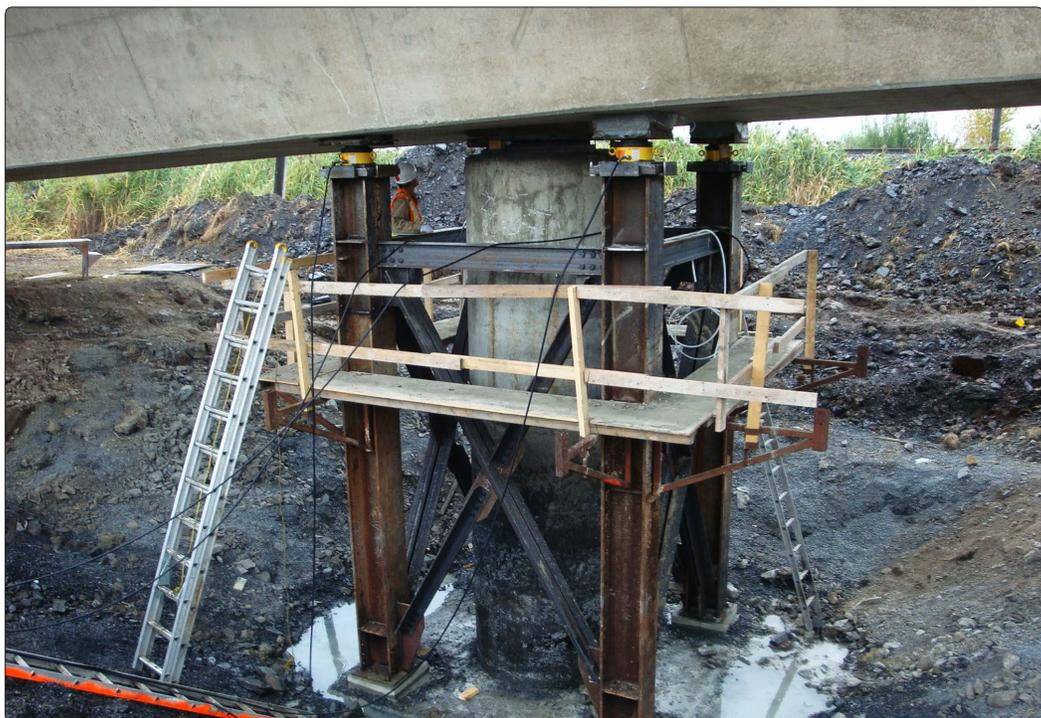
Dispositif de levage pour la réfection de l'appareil d'appui Pile #2
