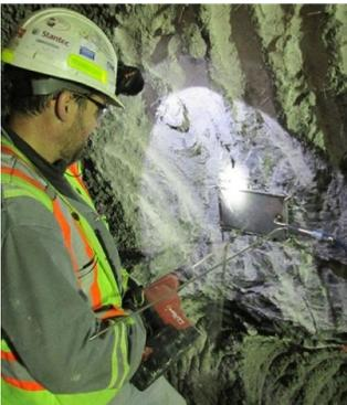
Cellules de pression NATM installées à la jonction du revêtement du tunnel en béton projeté et du terrain naturel
