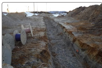
♦ Câbles en tranchées
