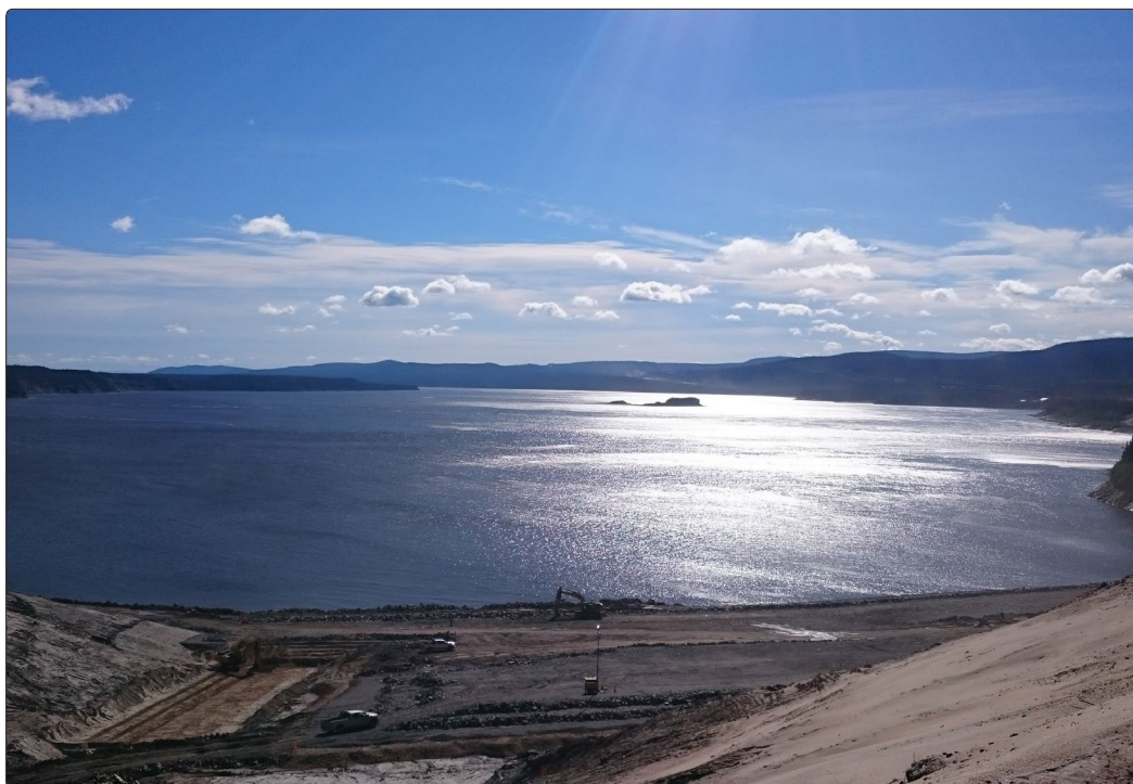
Muskrat Falls, section North Spur, vue en aval
