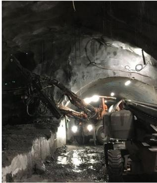
Installation des extensomètres simples dans le tunnel
