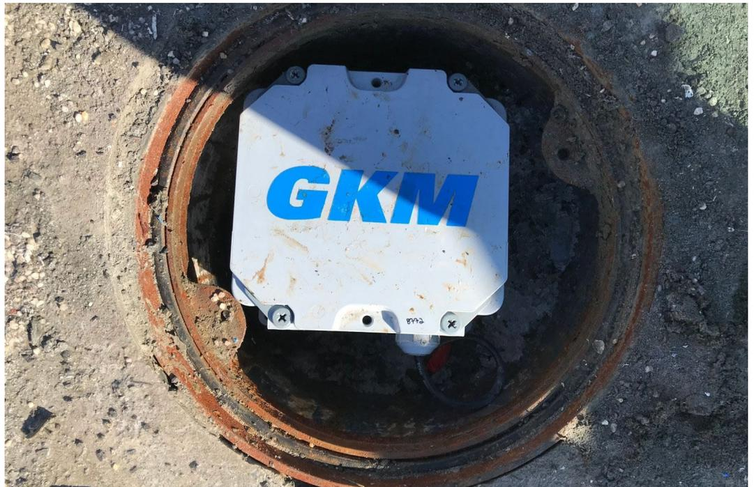
Acquisition de données - en temps réel - intégré dans une boîte de service
