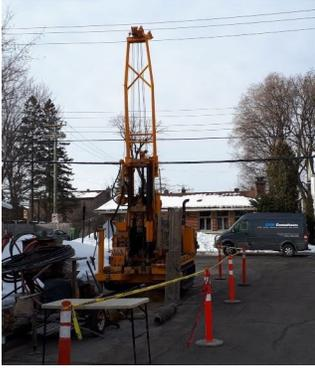
Forage et installation des extensomètres multipoints
